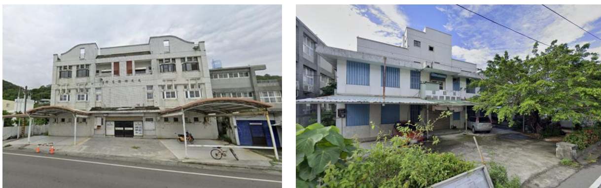
圖 3-2 本案基地現況地上物(左：前棟，右：後棟)
