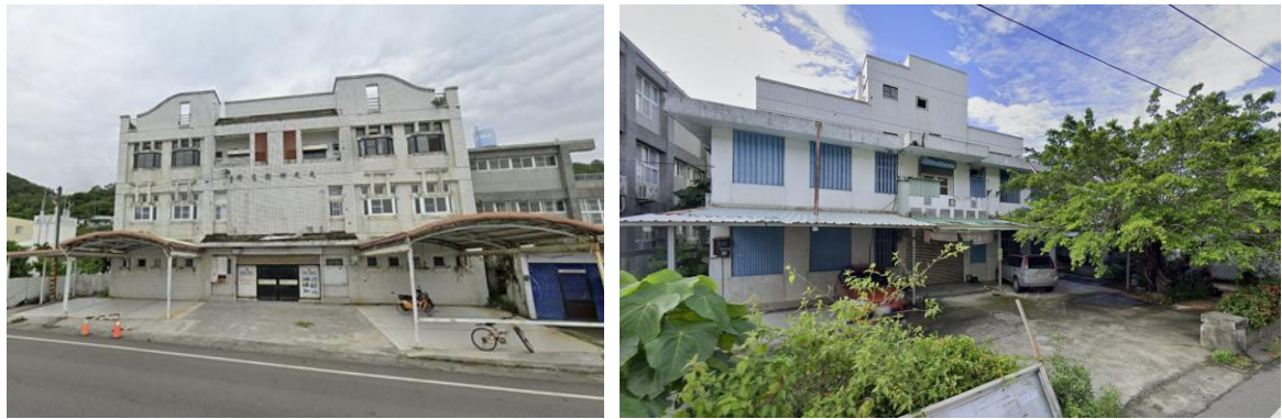
圖 6-1 本案基地現況地上物(左：前棟，右：後棟)
