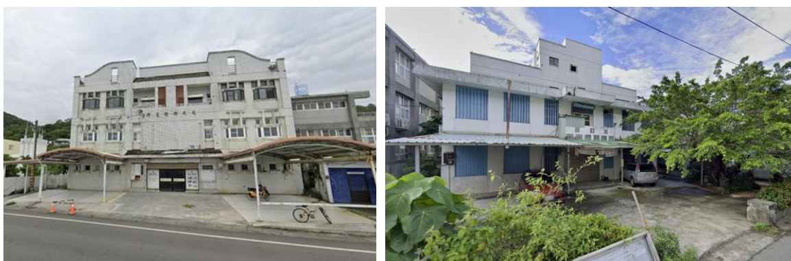
圖 3-4 本案基地現況(左：前棟，右：後棟)
